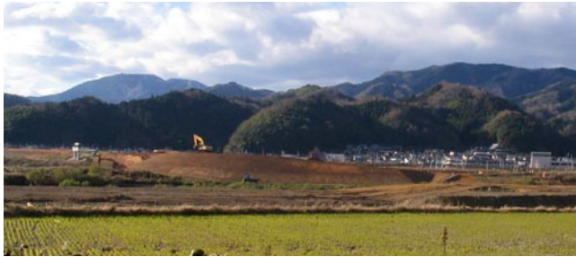
(写真) 災害に強いまちづくりを(河守築堤工事風景)
